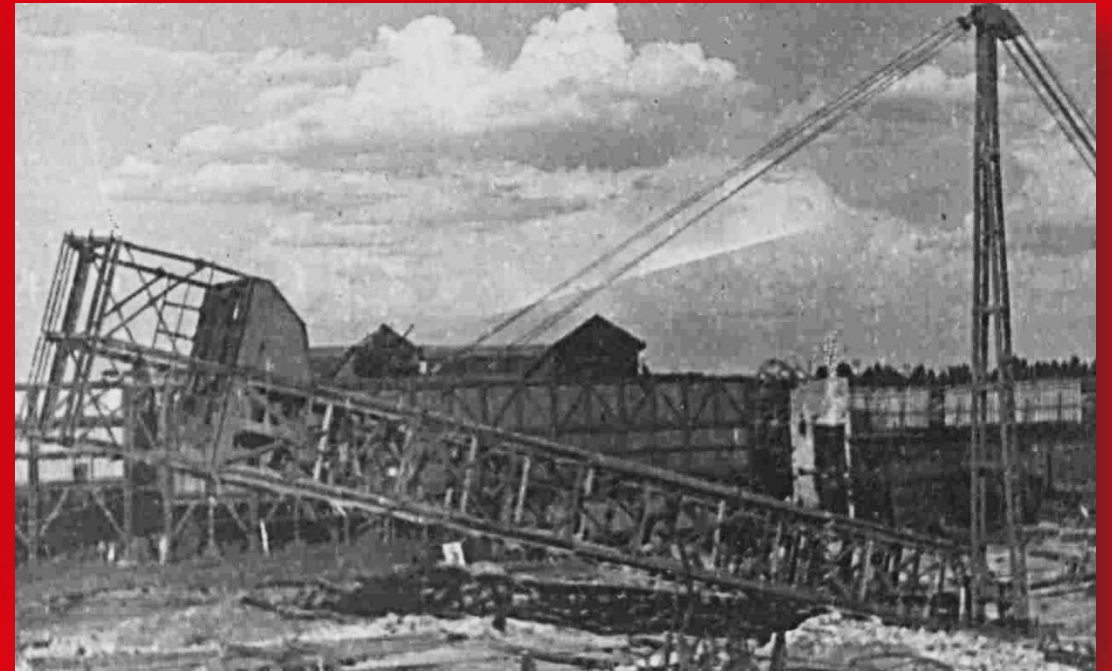
Подъем 28 метрового копра при помощи падающей стрелы. Город Шахты. 7 сентября 1944 г.
